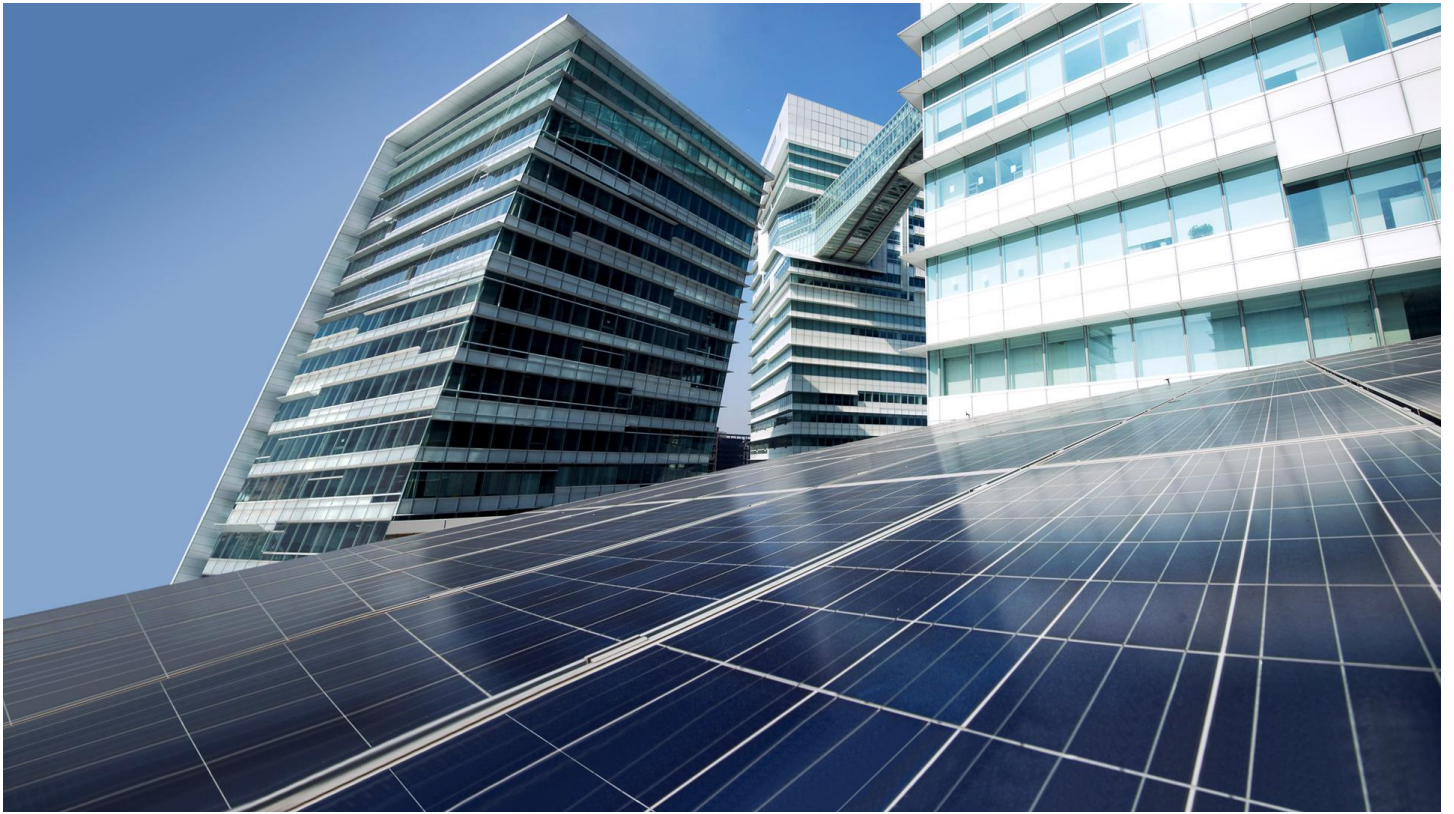
【圖說二】中國信託金融園區裝設總面積達 699 平方公尺的太陽能板，落實低碳建築的願景。 / 中信銀行提供
